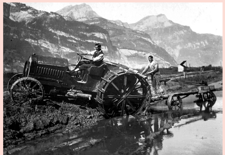
Foto rechts: Anfang der 1920er-Jahre wurde der Giessen-Kanal gebaut. Bild oben: Bei den Bauarbeiten am Giessen-Kanal kam ein Traktor zum Einsatz.
