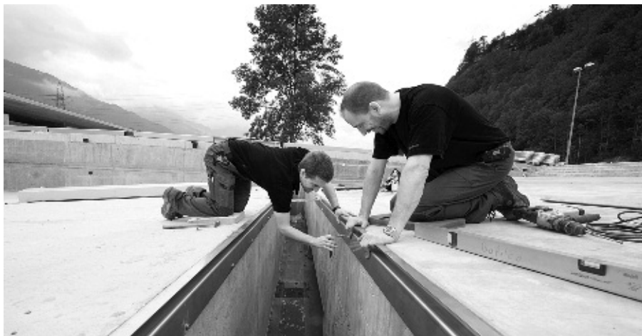
Noch ist das Becken leer: Zwei Arbeiter bei der Fertigstellung des neuen Wellenbades.
