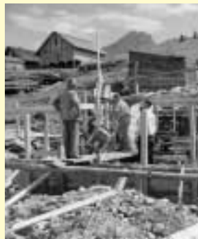
Foundation der Bergstation
