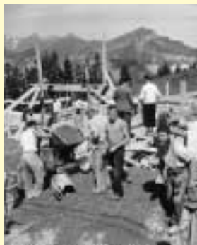
Bauarbeiten an der Bergstation
