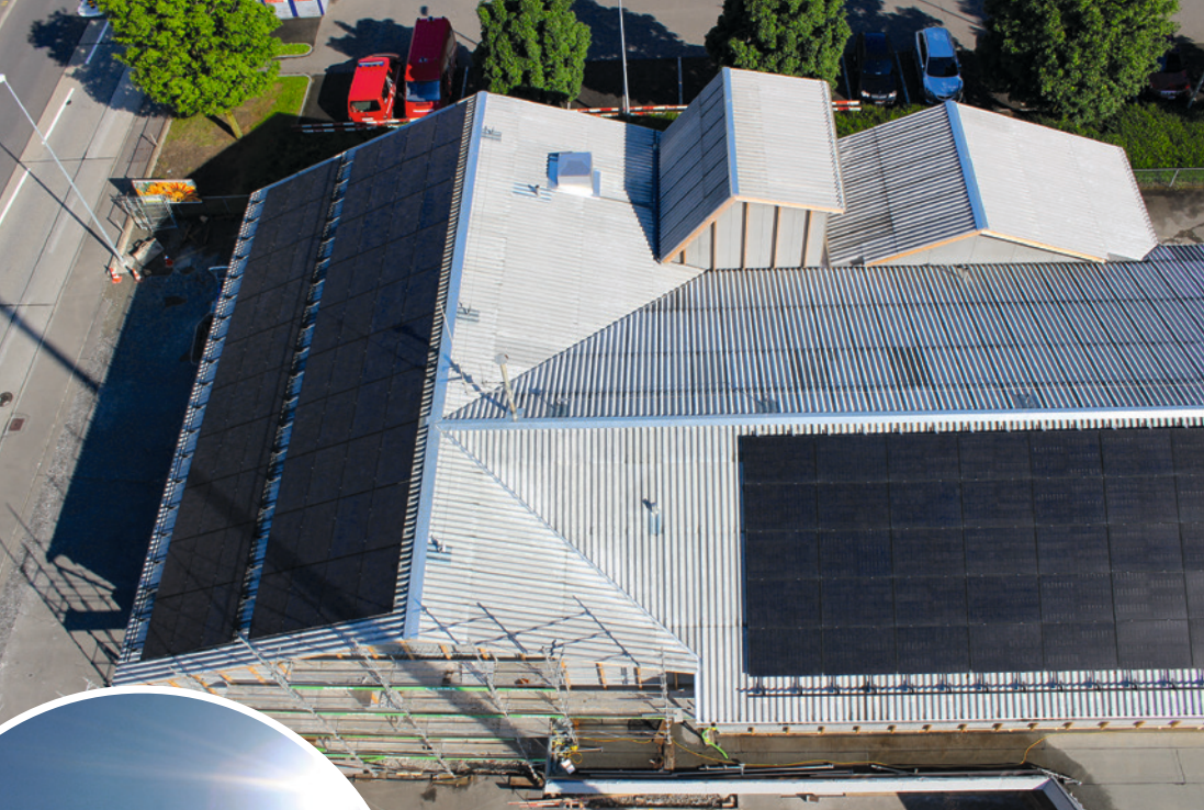
Fotos: Solarstromanlage Turnhalle/Aula Hagen (links) und auf dem rundum erneuerten Feuerwehrlokal (rechts).
