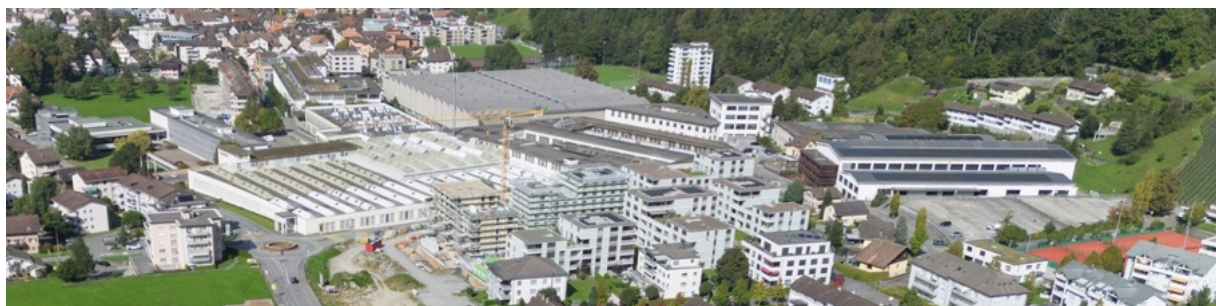
Abb. 19: Blick von Süden auf Turmmatt (W3/W4) im Vordergrund und Dätwyler-Areal/Industriezone 1 dahinter
