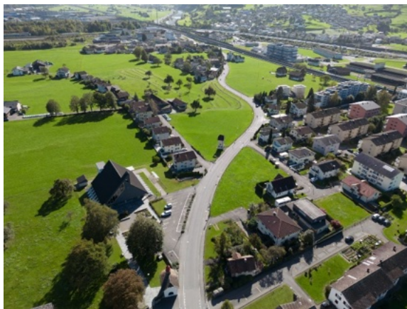
Abb. 35: Ansicht Richtung Süden, Schachengasse in Bildmitte
