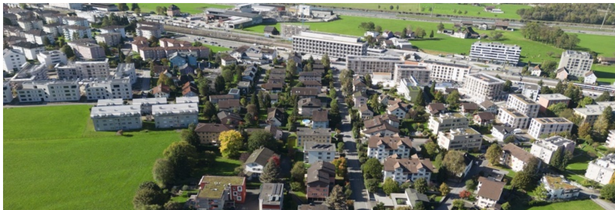
Abb. 24: Blick von NE auf Bahnhofstrasse mit Kantonsbahnhof im Hintergrund, MFH Quartiere Bauernhof + in der Matte (links), neue MFH Acherweg/Hagenstrasse rechts
