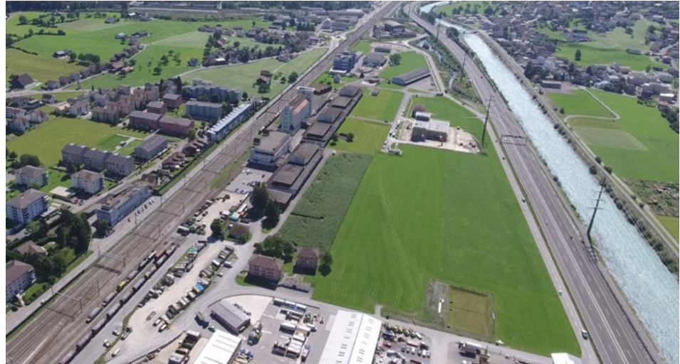
Abb. 32: Blick von Norden auf Industriezone 2, Werkmatt/Eyschachen
