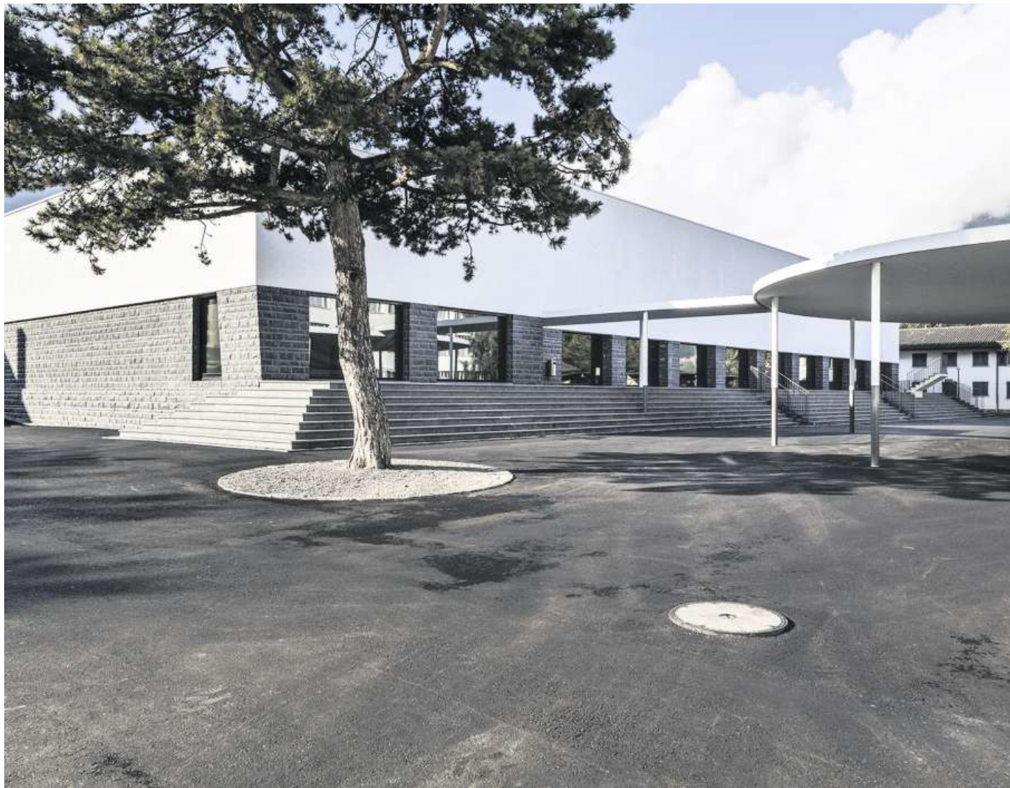
Die Turnhalle Hagen erfüllt als einzige Turnhalle in Uri den Minergiestandard.
