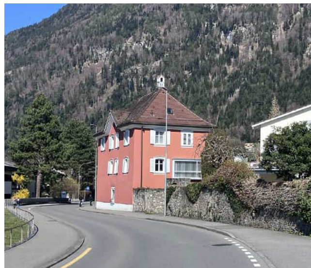
Gebäude als Akzent an der Attinghauserstrasse
