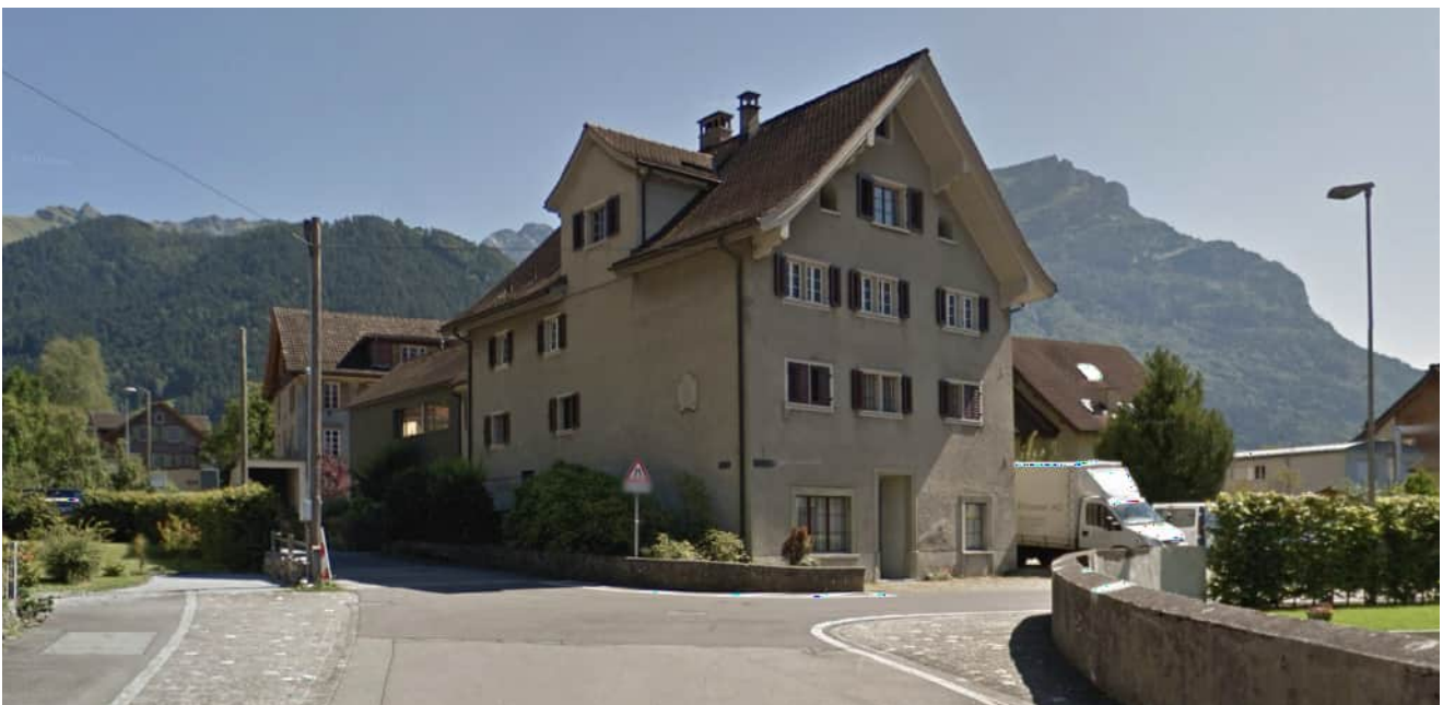
Das ehemalige Mühlegebäude als markanter und die Situation prägender Bau an der Kreuzung Hellgasse – Hochmühlegasse
